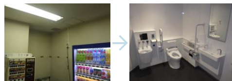
1階 多目的トイレの新設
