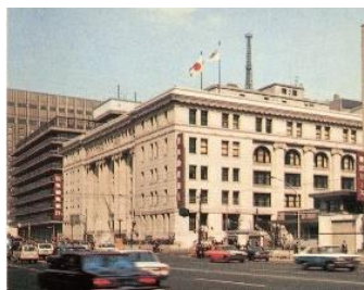
旧 第一勧業銀行本店ビル
