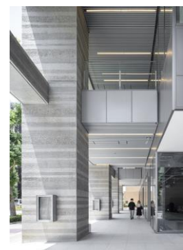
After：補強された既存躯体を活用
