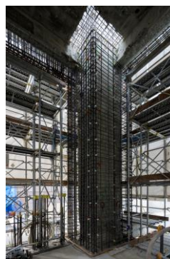
躯体を補強するため周囲に配筋
