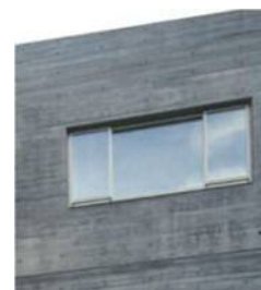
杉板型枠打ち放し コンクリート (イメージ)
