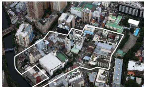
2011 年撮影(既存建物解体前)
