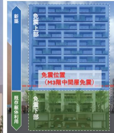
従前建物の地下から地上2階までの躯体を再利用する環境配慮型の免震オフィスビル計画です。従来の建て替えと比較し解体時52%、新築時37%のCO<sub>2</sub>を削減するほか、中3階に中間免震層を設け、既存躯体の再利用と災害対策を両立させました。太陽光発電設備により年間約4.5tのCO<sub>2</sub>排出を削減するほか、非化石証書による再生可能エネルギー由来の電力を導入します。イベントにも対応可能な屋根付きの広場やシェアサイクルポートの設置により博多駅周辺の賑わい創出や回遊性向上を目指すほか、四季折々の樹木やパブリックアート、ベンチの配置などによって憩いの場を創出します。福岡市が創設したインセンティブ制度「博多コネクティッドボーナス」の認定を受けています。
